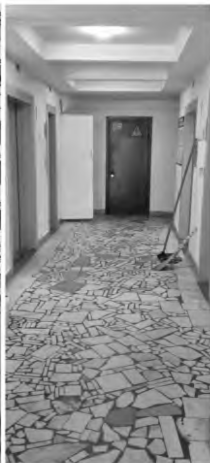
Лифт 1-го этажа
