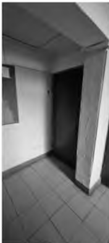
Вход в квартиру
